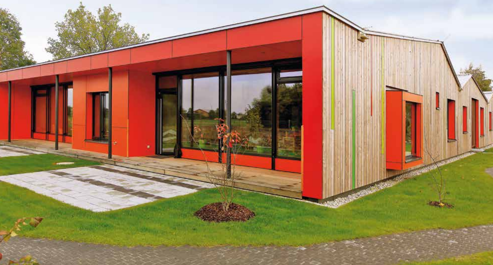
▲ Unbehandelte Lärche, farbige HPL-Platten und große Fenster bestimmen das Äußere der Kita Mering
